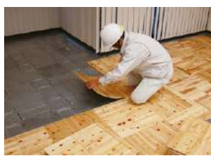
タイルカーペットと同じように施工していきます。
